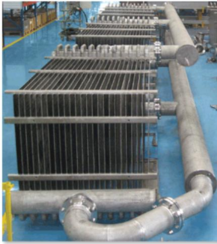
Эти устройства ECONOCOIL используются для "бесплатного" охлаждения речной водой.
