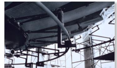
Большой бак для вязкой жидкости, усиленный рубашкой PLATECOIL на хомутах.
