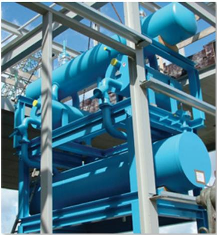
Компактный каскадный холодильный модуль. Под аммиачным сепаратором находятся два каскадных кожухо-пластинчатых теплообменника NH<sub>3</sub>-CO<sub>2</sub> и сосуд с CO<sub>2</sub>.
