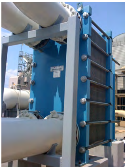
Эти пластинчатые теплообменники Tranter установлены на электростанции смешанного цикла, работающей на природном газе в США в качестве охлаждения замкнутой системы охлаждения.
